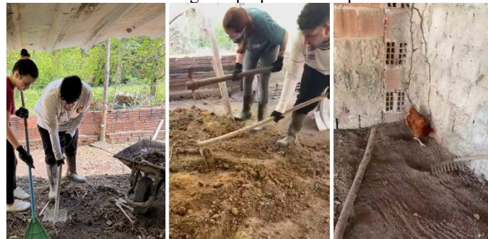
Figura 9 – Registros das etapas de limpeza e preparação do piso do galinheiro. Figure 9 – Records of the cleaning and preparation steps of the chicken coop floor.
