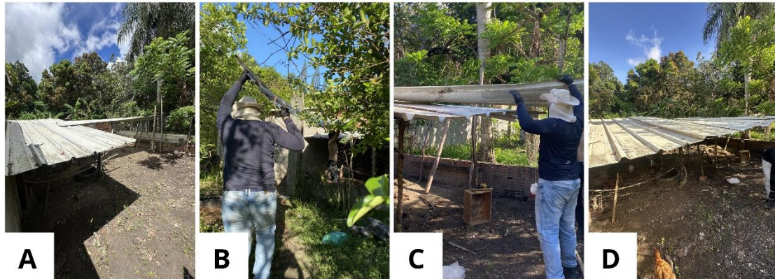
Figura 8 – Registros da etapa da expansão da cobertura do galinheiro: (A) Antes; (B) e (C) Durante; (D) Área coberta. Figure 8 – Records stage of the chicken coop cover expansion: (A) Before; (B) and (C) During; (D) Covered area.
